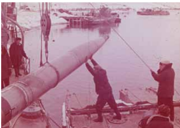
Укладка СПР на пусковой стенд
