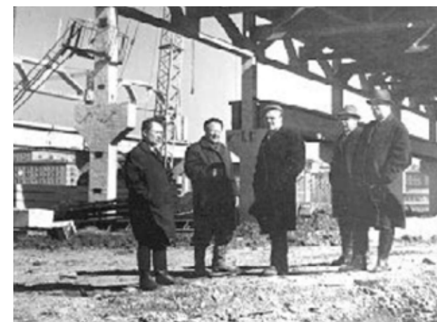
Осмотр строительства НИИПГМ
