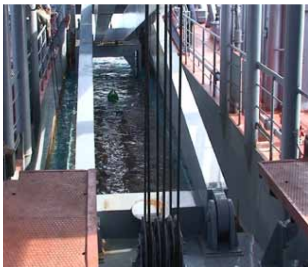
Подготовка к пуску
