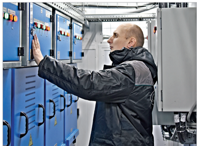
▶▶ Начальник паросилового цеха С.И. Соловьёв проверяет работу частотного преобразователя на сетевые насосы
